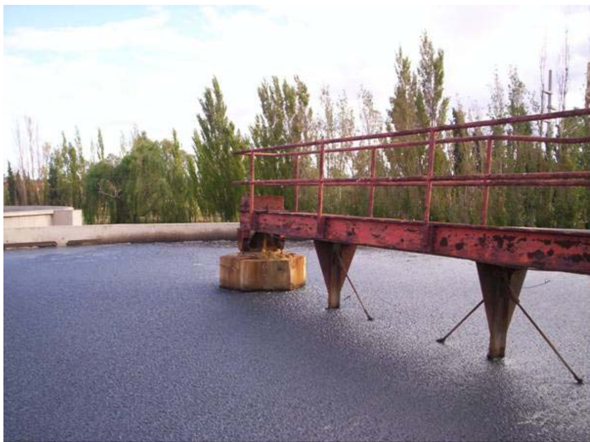
Fig. III.2.i. Sedimentador – Puente Barredor
