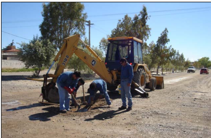
Foto II.5.7.6.f. Tareas necesarias para acceder a las bocas de registro en calles enripiadas
