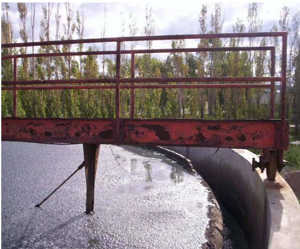
Fig. III.2.b. – Sedimentador – Puente Barredor
