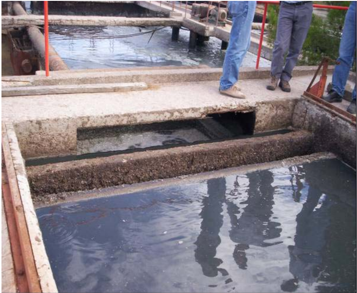
Fig. III.2.c Vertedero Cámara de Carga y Cámara de Carga de Cubas de Oxidación.
