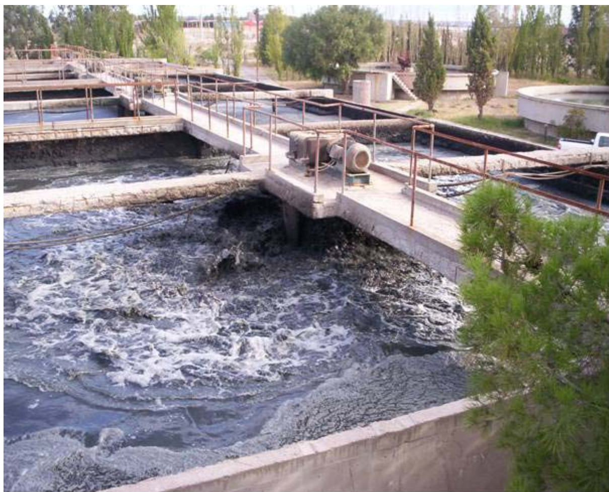
Fig. III.2.n. Cuba de Barros Activados con aireador en funcionamiento
