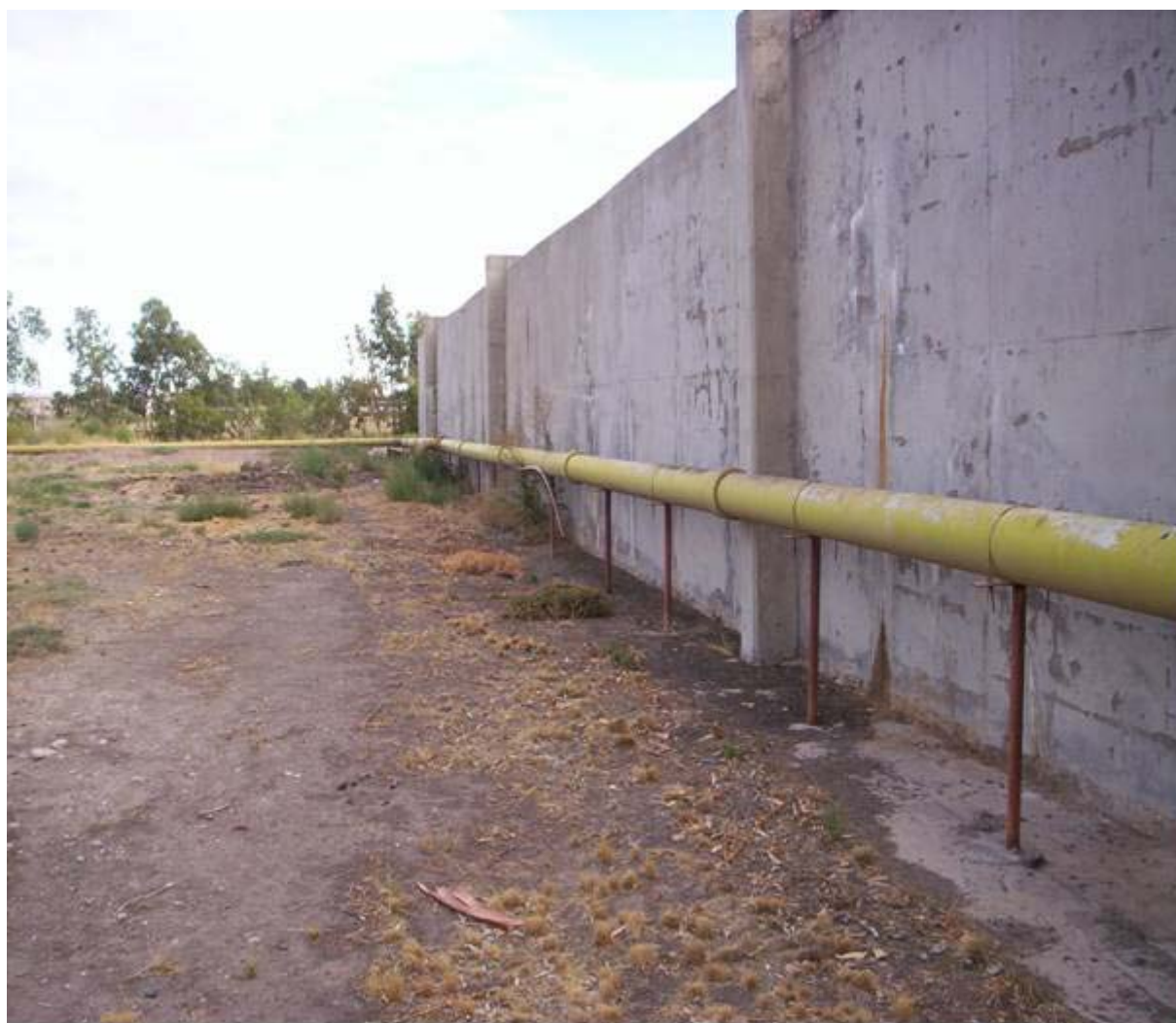
Fig. III.2.g- Cañería de descarga de limpieza de Cubas de Oxidación y de barros de Cubas de Digestión.
