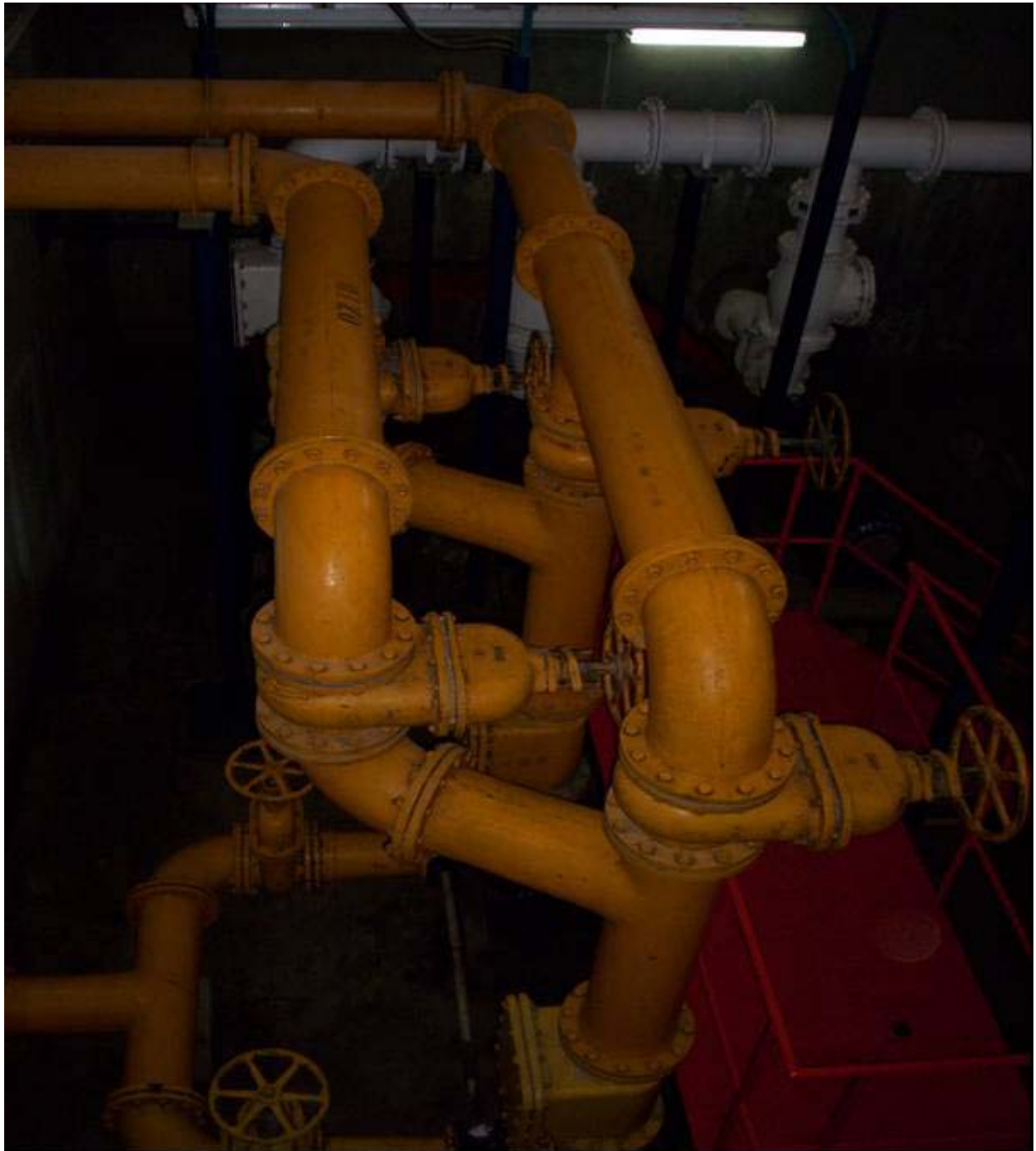
Fig. III.2.k. – Manifold de bombas de recirculación de Barros.
