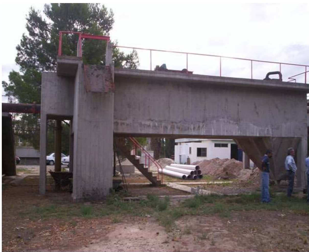
Fig. III.2.b Vista lateral del actual desengrasador – Futura cámara de carga
