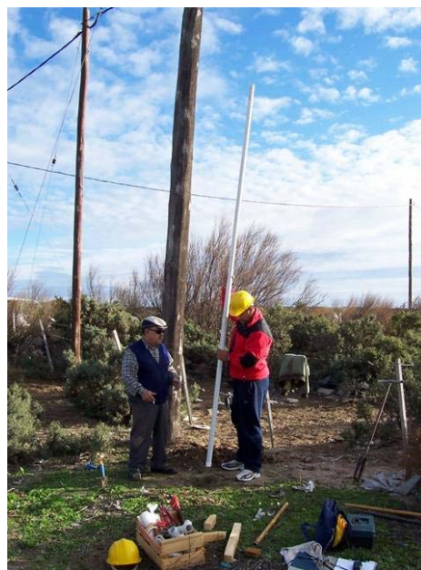
Foto 7.1.1.c Entubamiento del pozo
