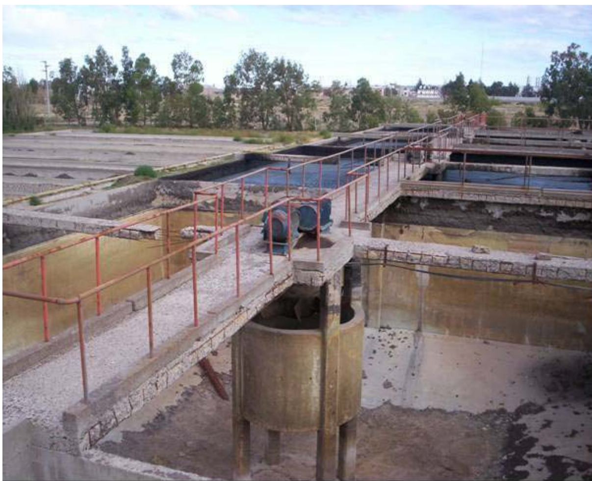
Fig. III.2.d Cubas de Oxidación – Vista del aireador Actiroctor.
