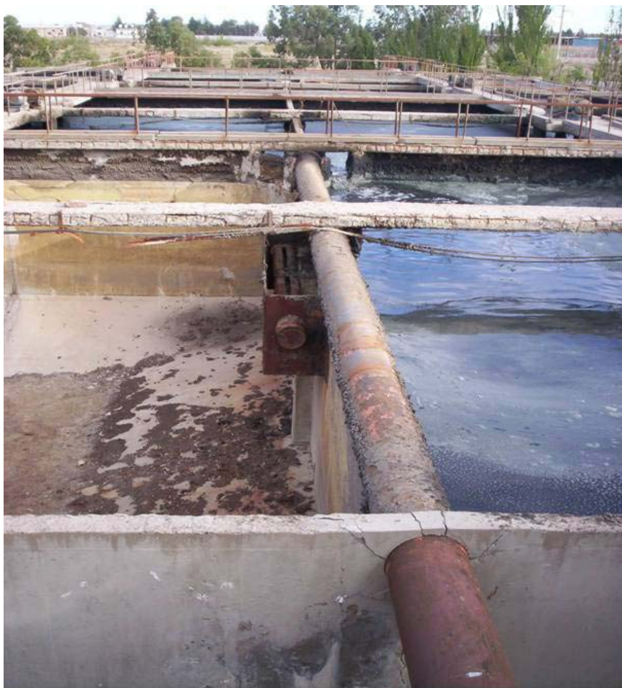
Fig. III.2.e Cubas de Oxidación – Cañería de entrada a cámara partidora – Cámara recolectora de líquidos aireados – Caminos de H 2 A° y barandas.
