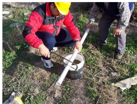
Foto 7.1.1.b Construcción de filtro ranurado
