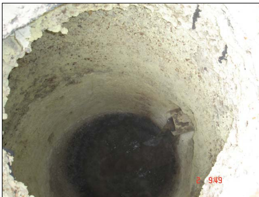
Foto II.5.7.7.a Colectora con presencia de sulfuros
