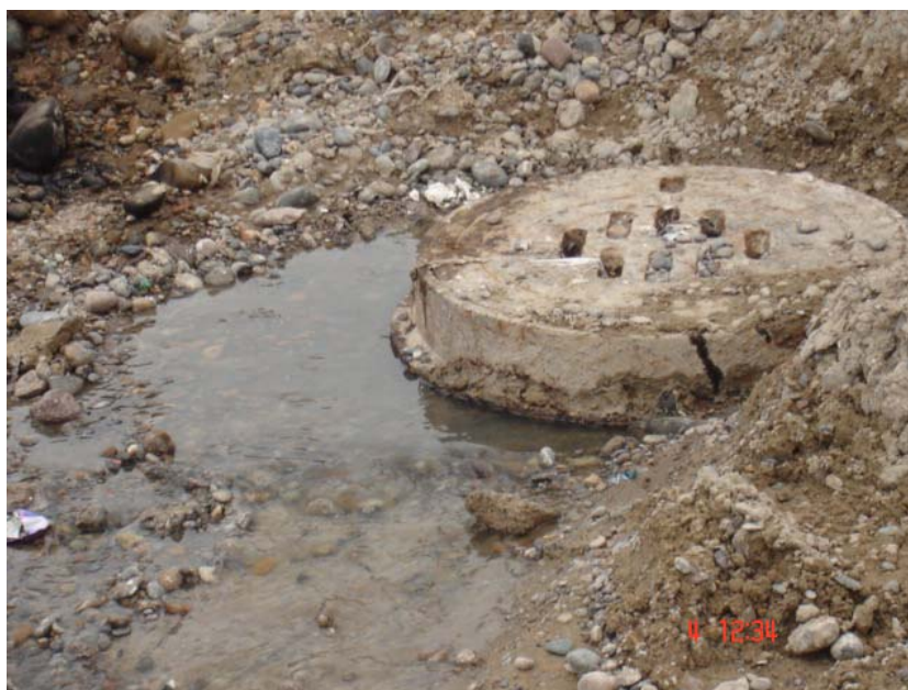
Foto II.5.7.6.d. Rebalse de una colectora
