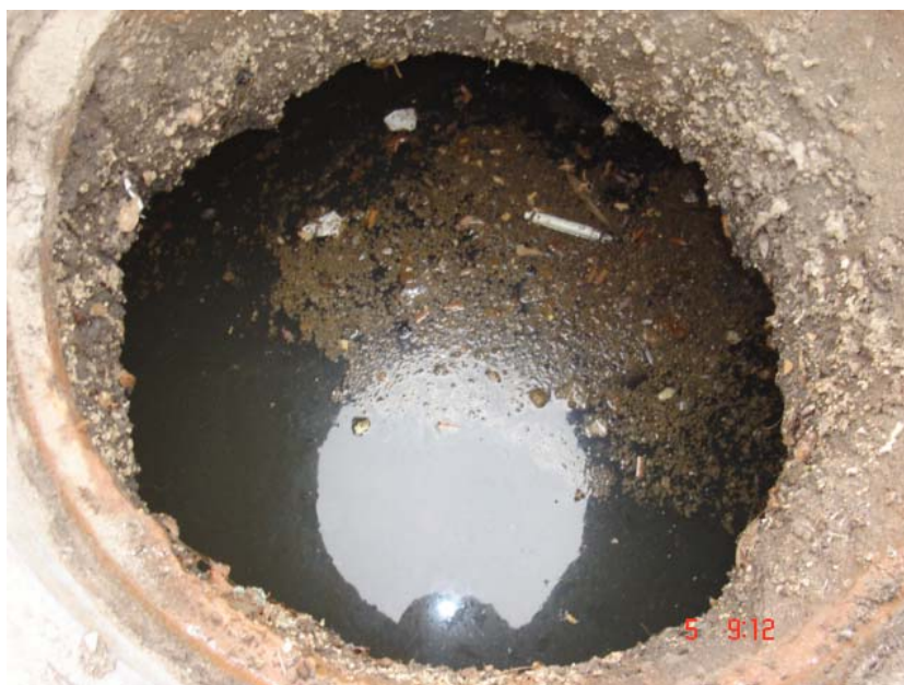
Foto II.5.7.6.c Colectoras que trabajan inundadas
