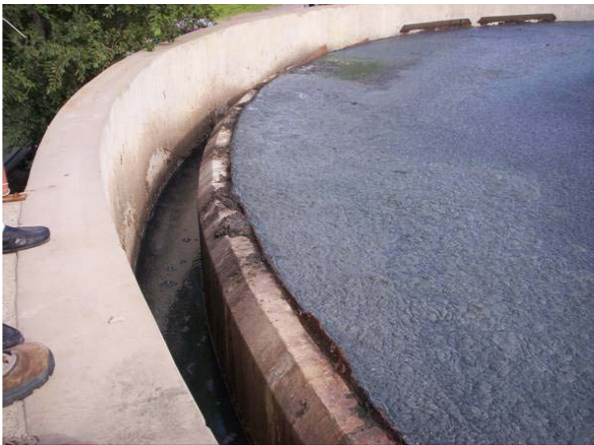
Fig. III.2.j. Sedimentador – Vertedero existente.
