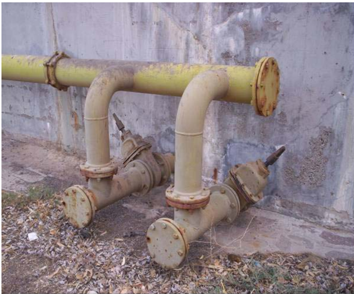
Fig. III.2.f – Válvulas de limpieza de barro de Cubas de Oxidación
