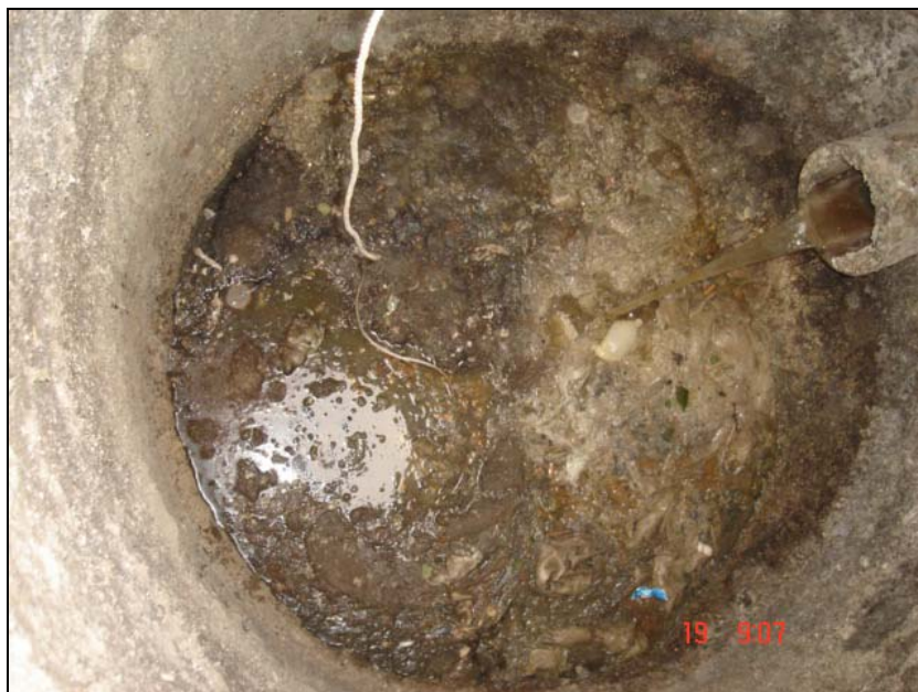
Foto II.5.7.6.a. Descarga de efluentes no domésticos
