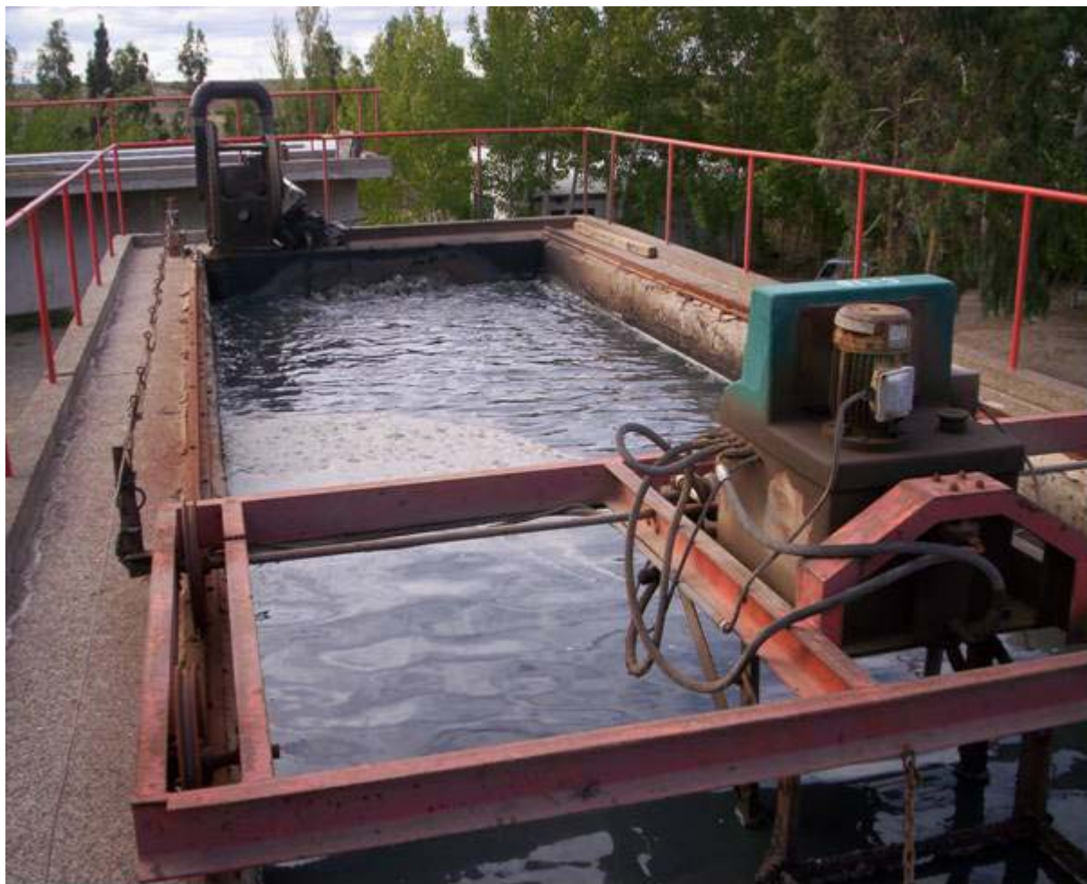
Fig. III.2.a Actual desengrasador – Futura Cámara de Carga
